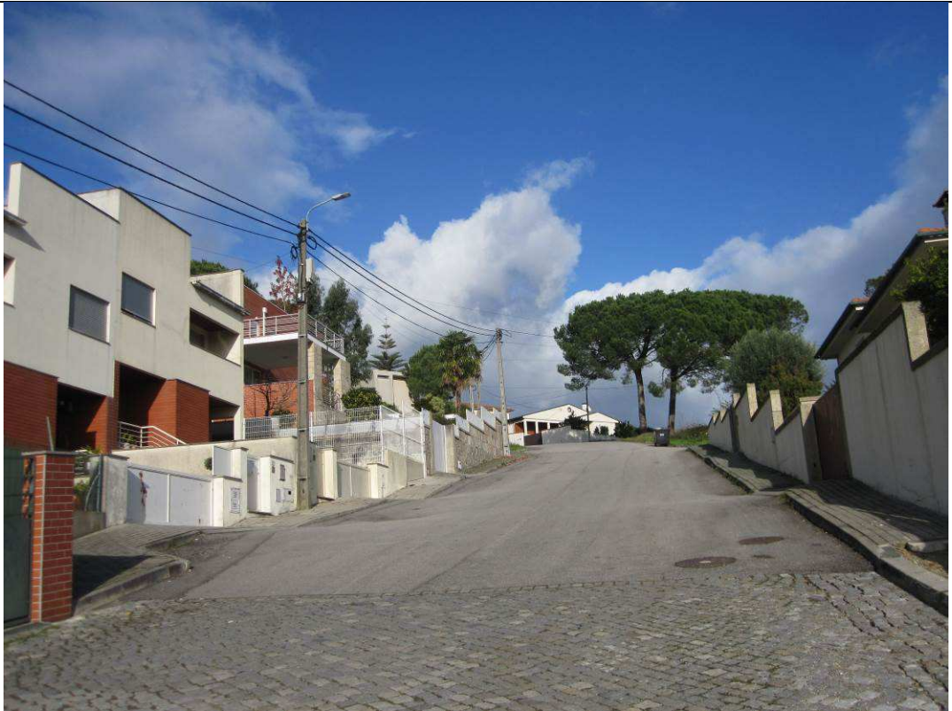
Foto 1: arruamento de acesso ao loteamento
